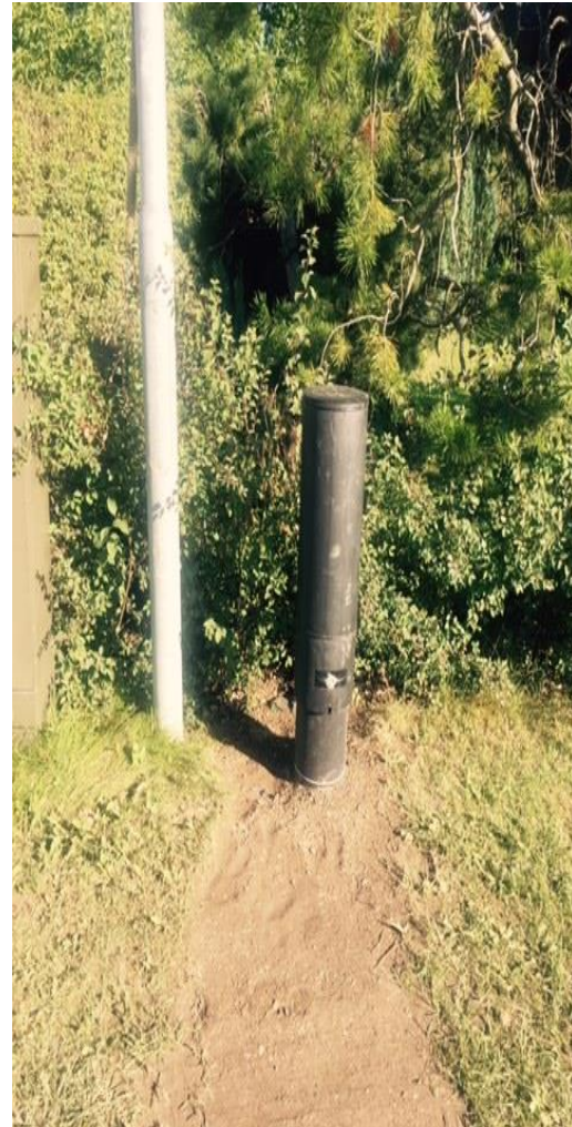
Bildene viser en montert pidestall med 24 stk. 7/4mm samt 2 stk. 20/16mm mikro rør. 7/4mm røret brukes til EPFU blåsefiber eller MTE mikro kabel og 20/16 røret brukes til G48, G96 evtnt. G192 mikro kabel.
