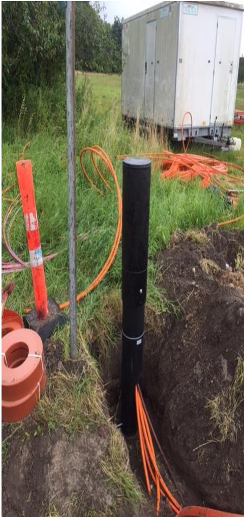
Bildene viser en montert pidestall med 24 stk. 7/4mm samt 2 stk. 20/16mm mikro rør. 7/4mm røret brukes til EPFU blåsefiber eller MTE mikro kabel og 20/16 røret brukes til G48, G96 evtnt. G192 mikro kabel.
